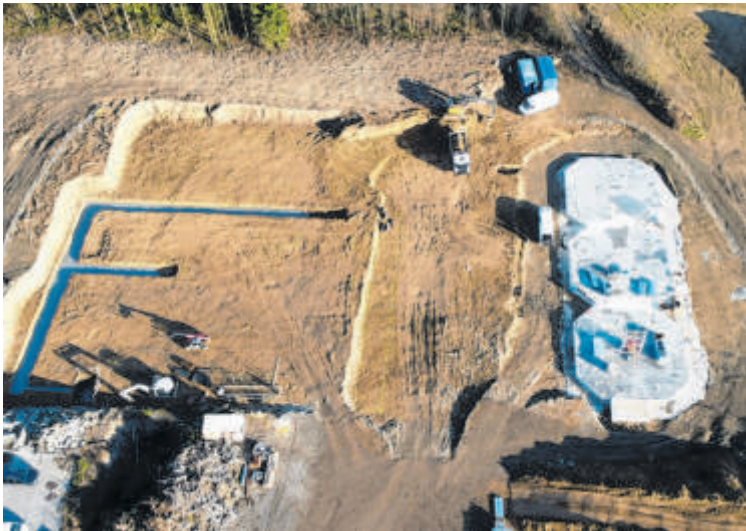
▲ Den Anfang machte das Betonfundament der Stahlsilos.
