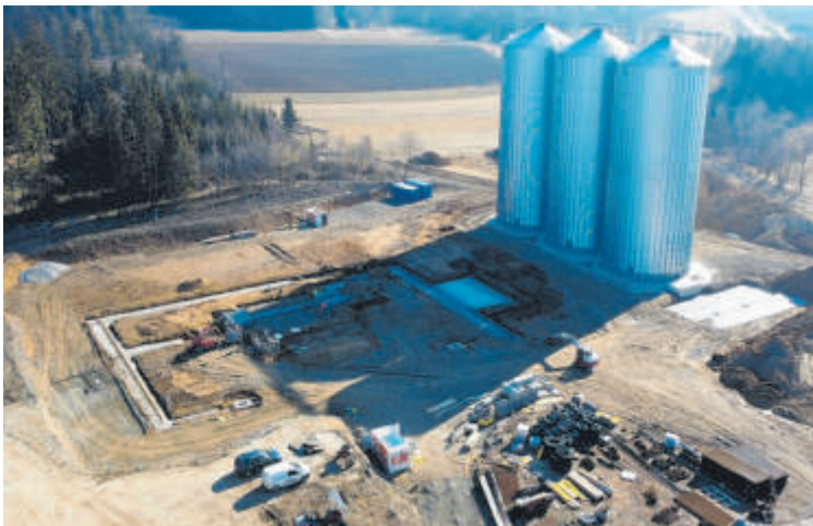
▲ Zügig standen dann auch schon die drei markanten Silos, die auf der Bundesstraße schon von weitem ins Auge stechen.
