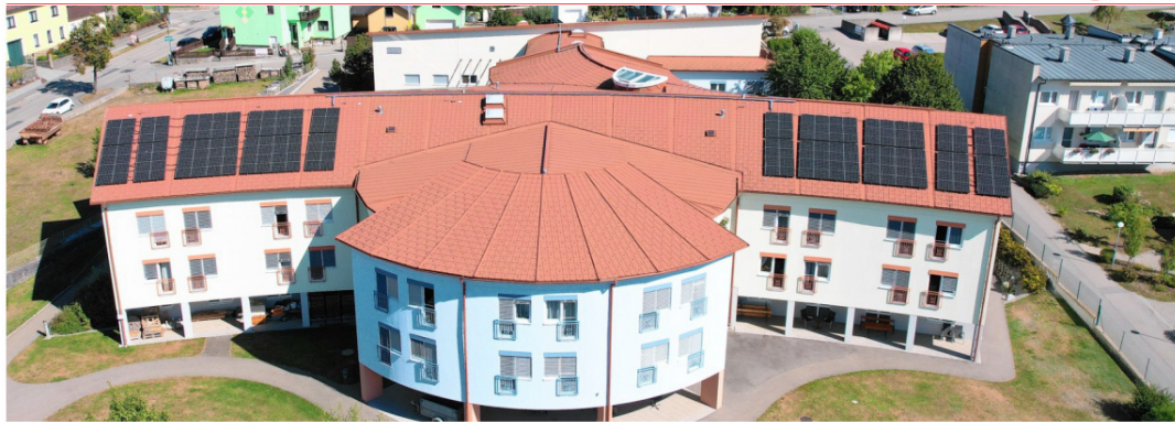
▲ Die Dächer des Pflege- und Betreuungszentrums Schrems liefern seit einigen Tagen Strom. Der Plan dahinter – und hinter etlichen weiteren großen PV-Projekten – wurde in Gmünd entwickelt. Foto: Günter Fürnkranz
